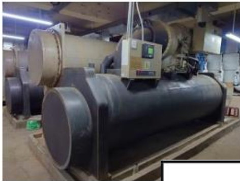
冷凝器趨近溫度差檢查-1
